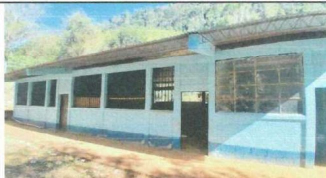
Foto 2: Sustitución yoyos. Por tubos rectangular 2x4.
