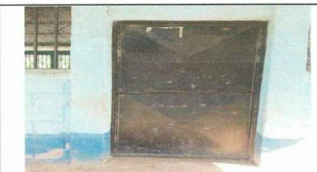
Foto 6: Mantenimiento de 4 puertas.
