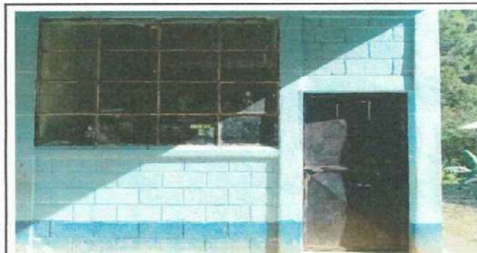
Foto 3: Cambio de ventana.
